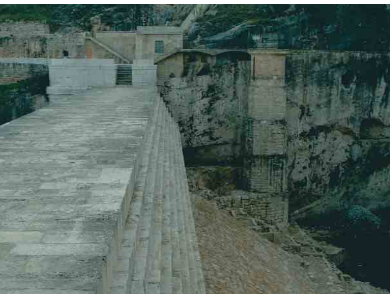
Presa del Pontón de la Oliva.
