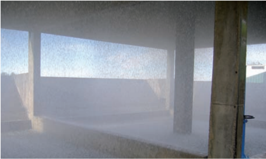
Torre de refrigeración
