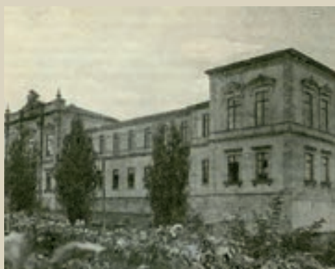
Vista general de la Escuela de Veterinaria de Santiago en el Pazo del Hórreo (1915) 1
