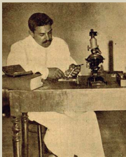
Jerónimo Fernández Domínguez. El autor depositando una gota de disolución en el hematímetro con el aspirador de precisión y seguridad para efectuar el examen microscópico. Escuela de Veterinaria Santiago. 1912 18
